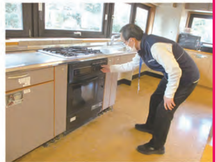
調理室のスイッチ確認作業
